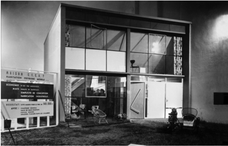
CECA-huis, prototype op de Internationale Jaarbeurs van Luik, 1954 © Archieven WVDM / A & D 50.
