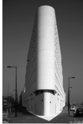
De Witte Kaap in Amsterdam door Claus en Kaan Architecten, Foto Luuk Kramer.
