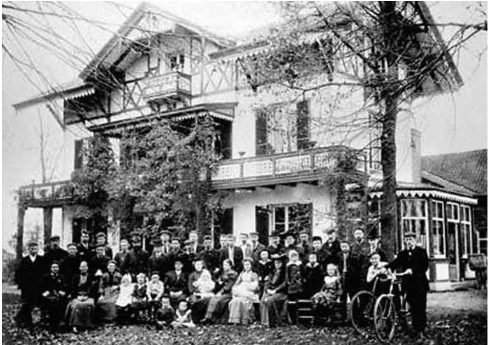
De bewoners van de door Frederik van Eeden gestichte kolonie Walden (bij Bussum) voor Groot Cruysbergen, het centrale gebouw van de kolonie.
