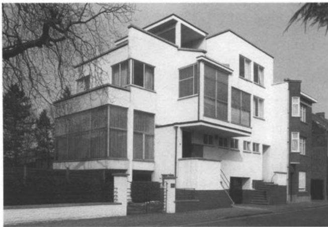
Huib Hoste, woning Haegens in de Stationsstraat in Zele, Oost-Vlaanderen, 1930 – Foto Ch. Bastin en J. Evvard.
