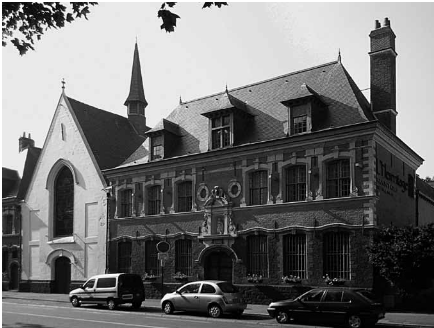
La salle des malades et la chapelle de l'hospice Gantois à Lille
