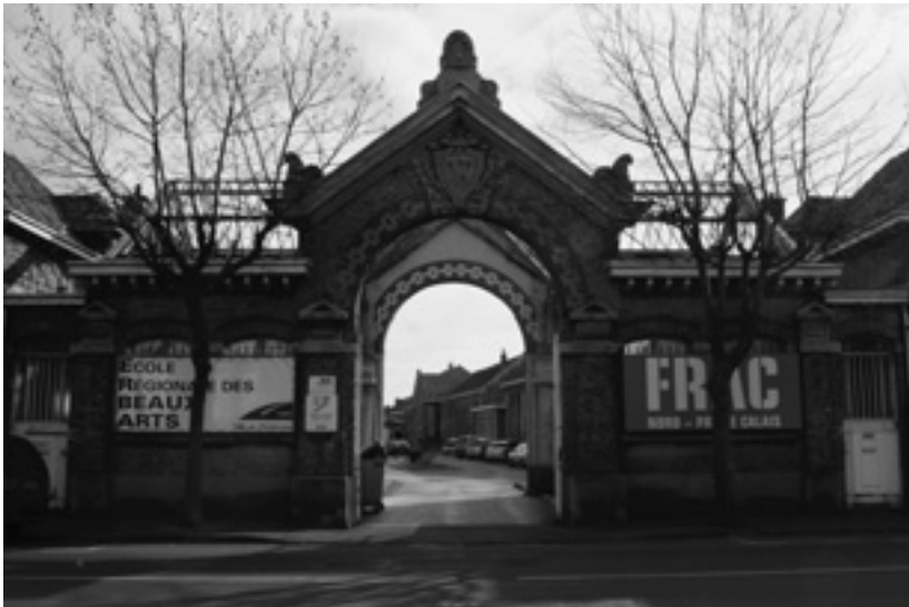
Ingang van de huidige locatie van de FRAC-Nord-Pas-de-Calais in Rosendaël (Duinkerke)
