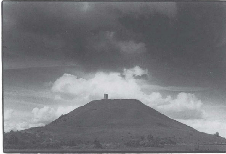
8. Een kabelbaan op een steentort in Noeux-les-Mines. Des vestiges de téléphérique sur une décharge de schistes de Noeux-les-Mines.
