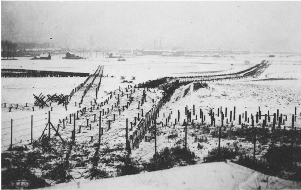
Anti-tankbarricade, 21 januari 1940. Aan de horizon liggen Halewijn en Menen (Imp. War Mus., London).
